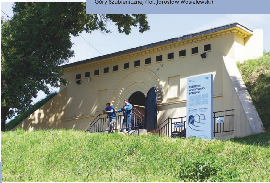
Wejście do ponadstuletniego zbiornika wodociągowego wkomponowanego w zbocze Góry Szubienicznej (fot. Jarosław Wasielewski)
